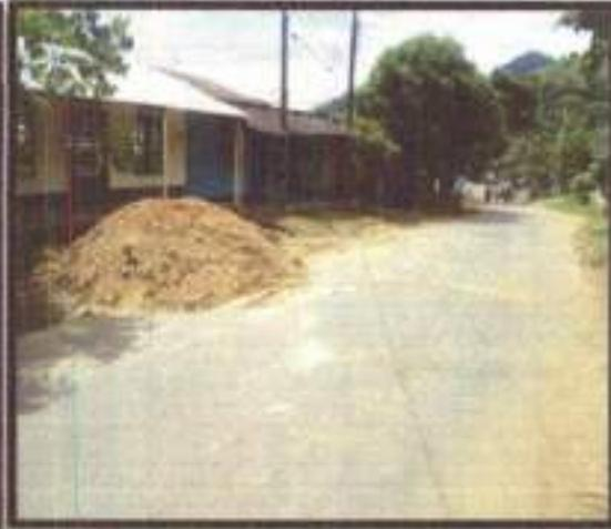
INSPECCIÓN DE RELLENO INSTALADO PARA PAVIMENTACIÓN SOBRE CALLE 3N, REVISIÓN DE COMPACTACIÓN Y MATERIAL EMPLEADO.
